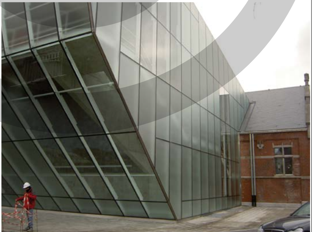
Zelfdragende gevel in extern verlijmde beglazing – VEC (Five-S 90°-systeem – Atelier du Verre) Théâtre du Manège, Mons – Atelier d'Architecture Pierre Hebbelinck _Façade autoportante en vitrage extérieur collé – VEC (système Five-S 90° - Atelier du Verre) Théâtre du Manège, Mons - Atelier d'Architecture Pierre Hebbelinck - © Atelier d'Architecture Pierre Hebbelinck
