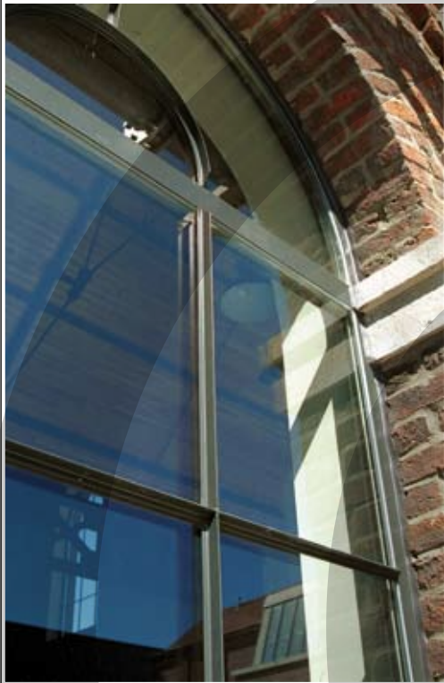
Renovatie Bois du Cazier, Marcinelle – Metalen schrijnwerk Dalla Valle, Metal.Quartz _Rénovation Bois du Cazier, Marcinelle - Menuiserie métallique Dalla Valle, Metal.Quartz © Jean-Luc DERU/photo-daylight.com
