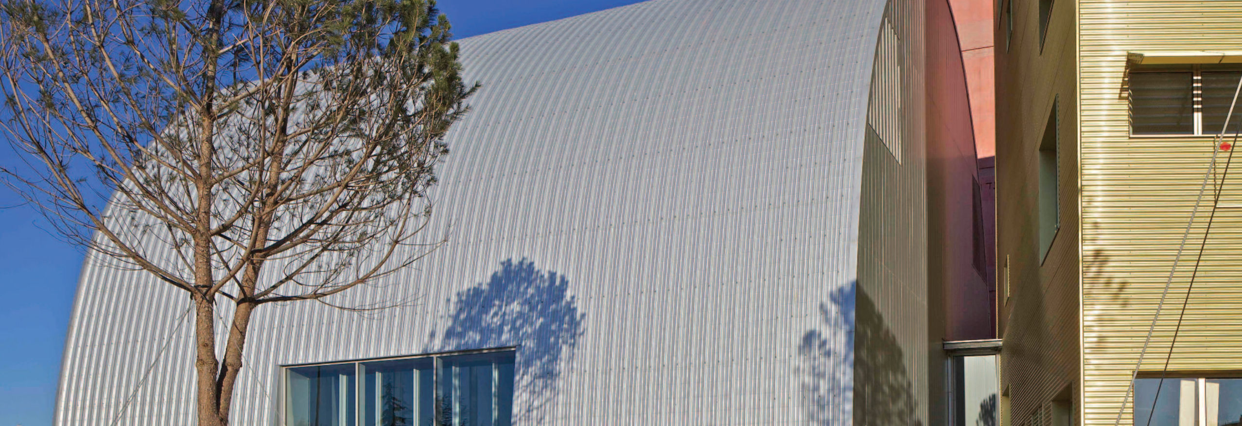
Project: Théâtre de l'Archipel, Perpignan, France Architects: © Ateliers Jean Nouvel & Brigitte Metra Associées Photography: © Philippe Ruault
