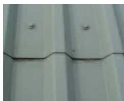
Toit en Colorcoat HPS200 Ultra® après 7 ans.
