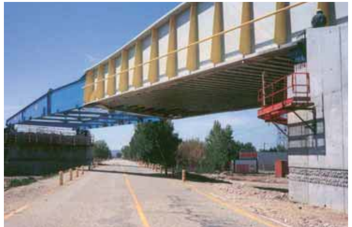
Cette photo représente le lancement d'un pont à poutres latérales de la LGV Méditerranée ouverte en 2002. Les semelles exposées des poutrelles enrobées transversales sont visibles en sous-face du tablier. La structure peinte en bleu, visible à gauche est l'avant-bec utilisé pour le lançage.
