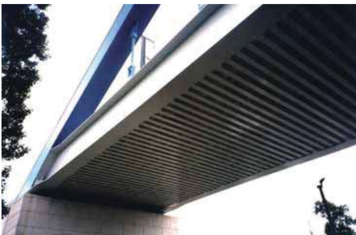
Cet exemple montre un pont en bow-string pour la LGV Méditerranée au dessus de l'autoroute A7 près d'Avignon (F). Le tablier est constitué de poutrelles enrobées placées perpendiculairement à l'axe du pont.
