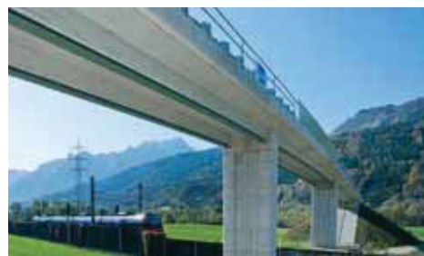
Vue du pont de Vigaun en PreCoBeam constitué de 3 travées de 26,15 m avec un élanement de 1/23.
