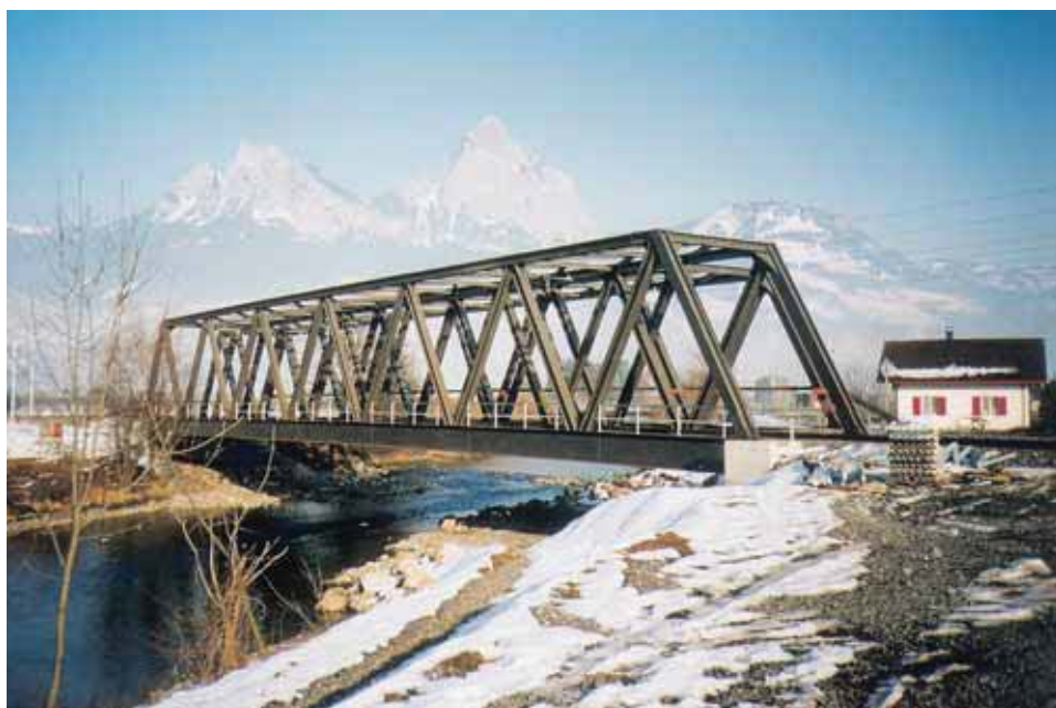
Nouveaux ponts-rails sur la Muota, ligne CFF du Gotthard, Suisse. - Les diagonales et les membrures supérieures sont des poutrelles laminées des séries HD et HE. Un acier thermomécanique a été utilisé en raison de ses bonnes propriétés de soudabilité.
