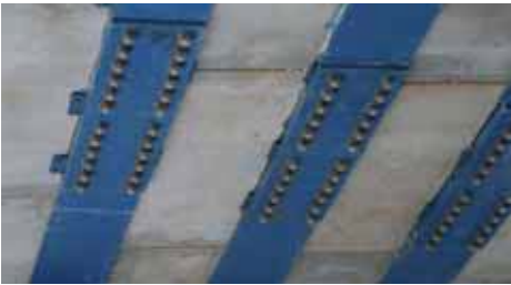
Connexion rigide par éclisses boulonnées
