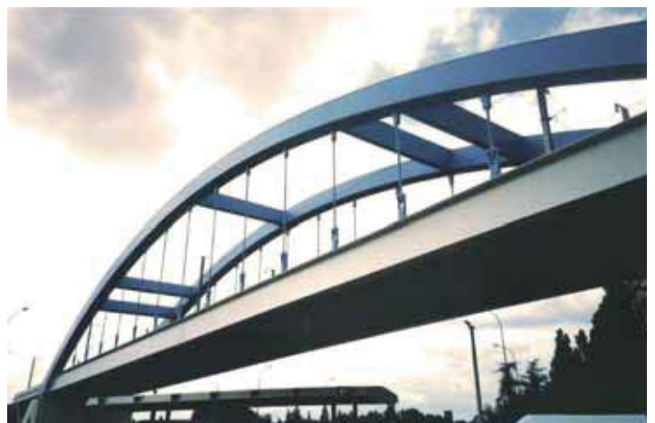
Cet exemple montre un pont en bow-string pour la LGV Méditerranée au dessus de l'autoroute A7 près d'Avignon (F). Le tablier est constitué de poutrelles enrobées placées perpendiculairement à l'axe du pont.
