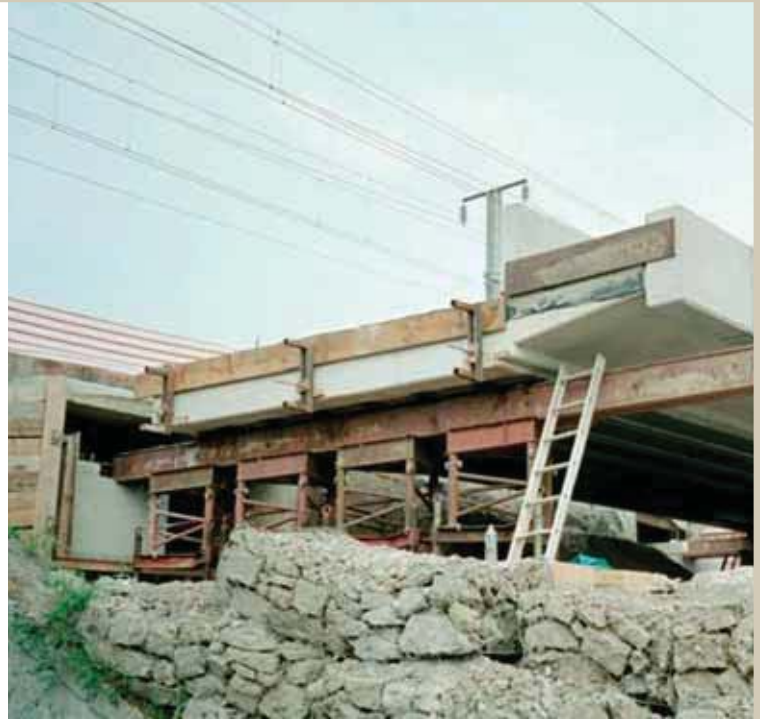
Ouvrage ferroviaire à Berchem au Luxembourg. Mise en place le long des voies d'un demi-ouvrage préfabriqué, sous circulation (en parallèle) à vitesse réduite.
