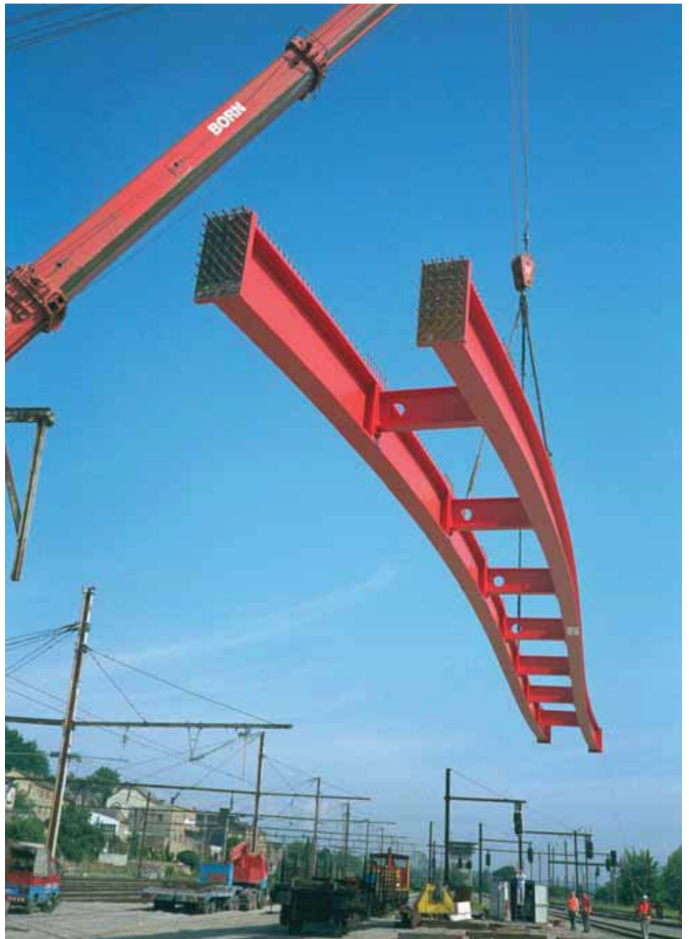
Pont routier à Differdange, Luxembourg – Montage à la grue de deux poutres maîtresses d'un pont mixte. Les poutrelles laminées ont été cintrées autour de leurs deux axes principaux afin de les adapter à la géométrie de la route portée.
