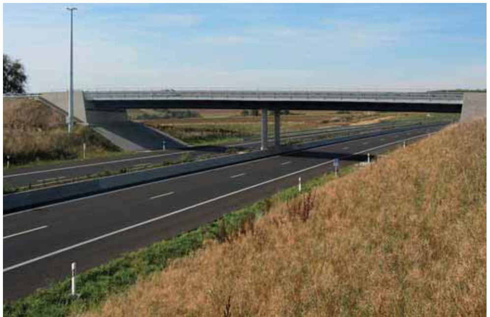
Pont à deux travées (de 23,90m) sur l'autoroute A13 vers la Sarre, Luxembourg - Le pont mixte est un bipoutre formé de caissons constitués de deux poutres laminées soudées entre elles longitudinalement.
