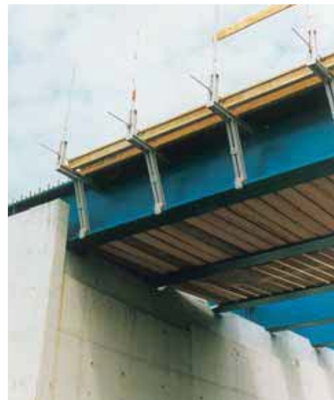
Exemple d'un support du coffrage de l'encorbellement.
