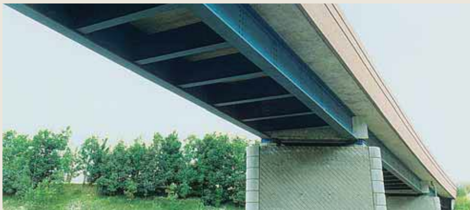
Pont de la ligne TGV Nord sur l'autoroute A23 à Fretin, France. - Tablier mixte à quatre travées de 16,9 - 21,9 - 23,0 - 17,8 mètres. Les deux poutres maîtresses et les entretoises en travée sont des poutrelles laminées; les entretoises sur appui sont en béton armé.
