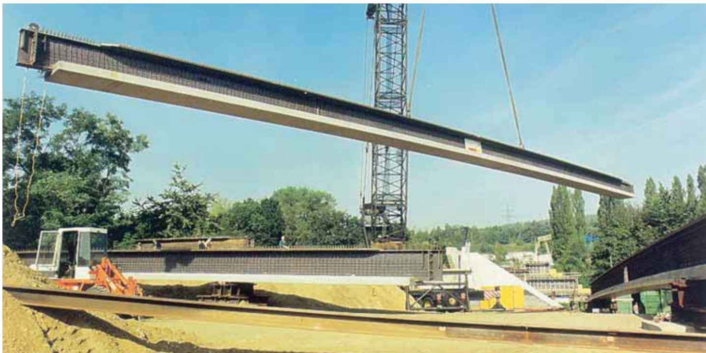
Construction d'un pont-route à une travée à Kerpen Horrem, Allemagne - Poutres mixtes préfléchies de type Préflex, à base de poutrelles laminées HEA 1000 de 41,25 m de longueur.
