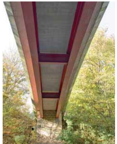
Vue de dessous des bi-poutres de la passerelle mixte à Wasserbillig, Luxembourg
