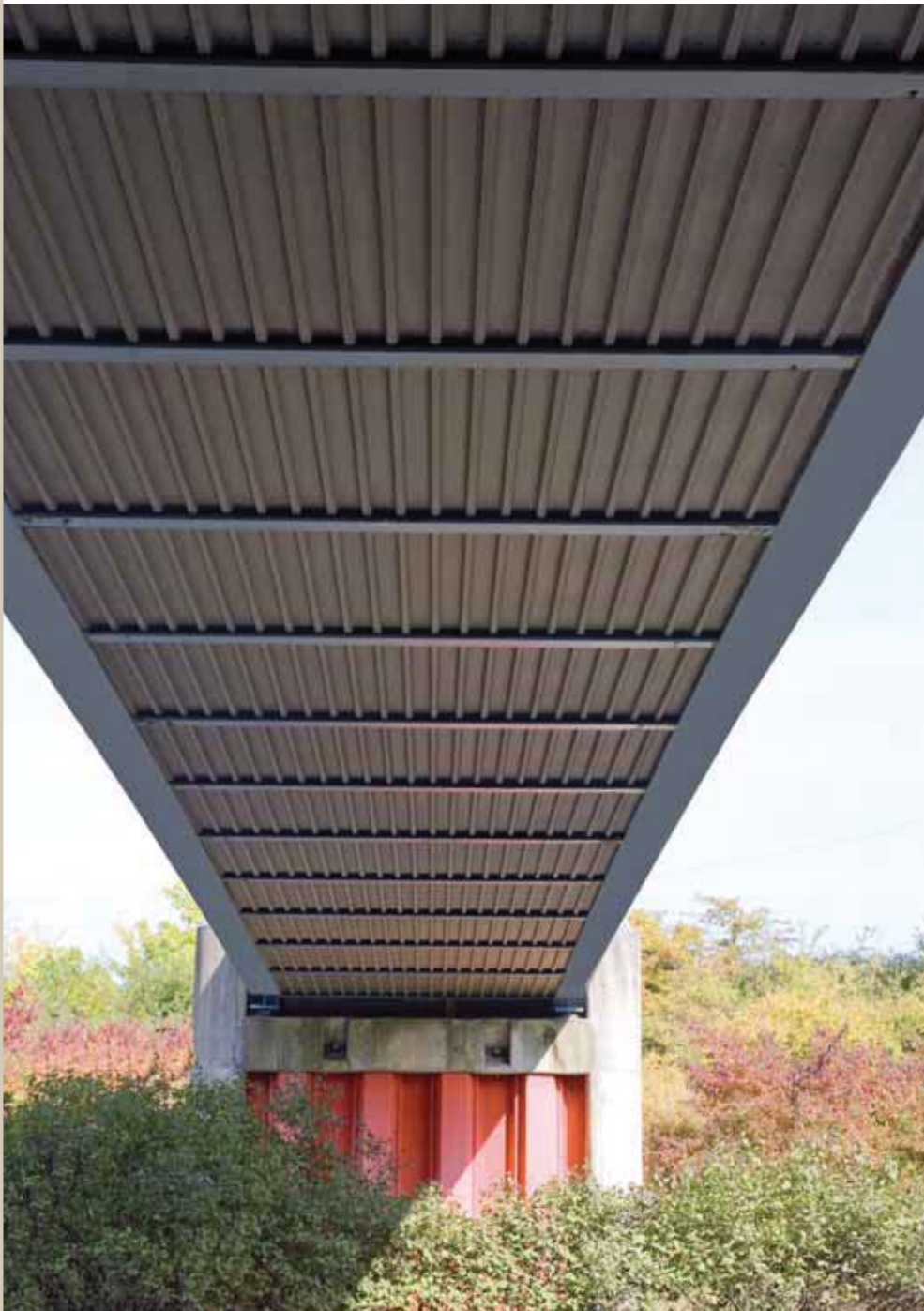
Vue de dessous de la passerelle à Soleuvre, Luxembourg – Les culées sont constituées de palplanches.
