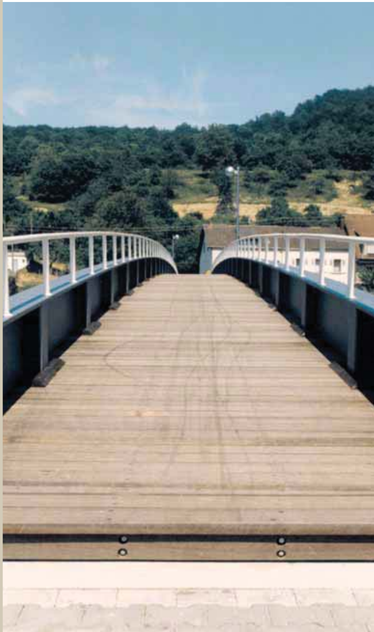
Vue du platelage en bois du pont à poutres latérales en profilés laminés de Steinheim, Luxembourg
