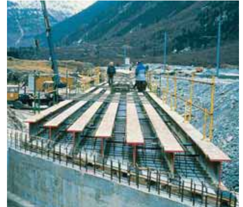
Construction d'un pont-rail à poutrelles enrobées dans le cadre de la réalisation du tunnel routier du Puy de la Vierge entre la France et l'Espagne.
