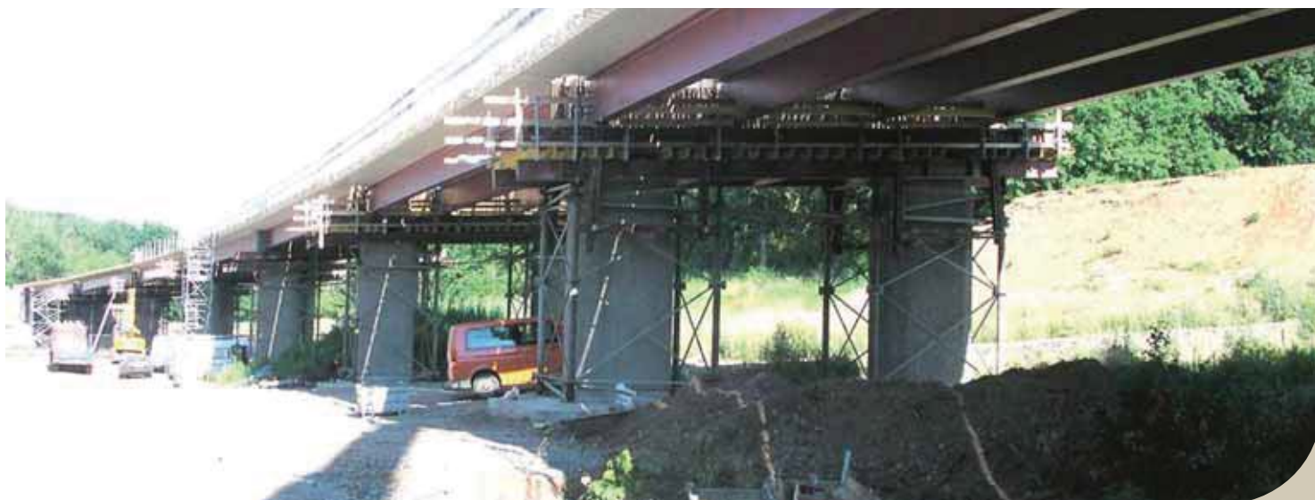
Cet exemple montre le pont à 8 travées Horloffthal à Hungen en Allemagne, construit en 2006. Sur 5 de ces travées, la poutraison est constituée de gros profilés laminés en qualité S460.
