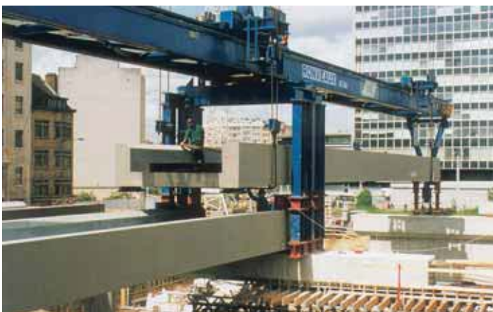
Extension de la gare de Bruxelles-Midi pour les trains Eurostar. - Mise en place rapide, à l'aide d'un portique, des tabliers préfabriqués à poutres latérales préfléchies et noyées dans le béton.
