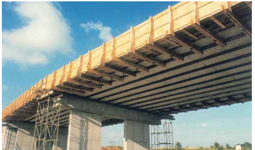
Construction d'un passage supérieur de l'autoroute A104, France. - Seul un étaielement au droit des piles est nécessaire. La perturbation de la circulation sur l'autoroute est ainsi minimale.
