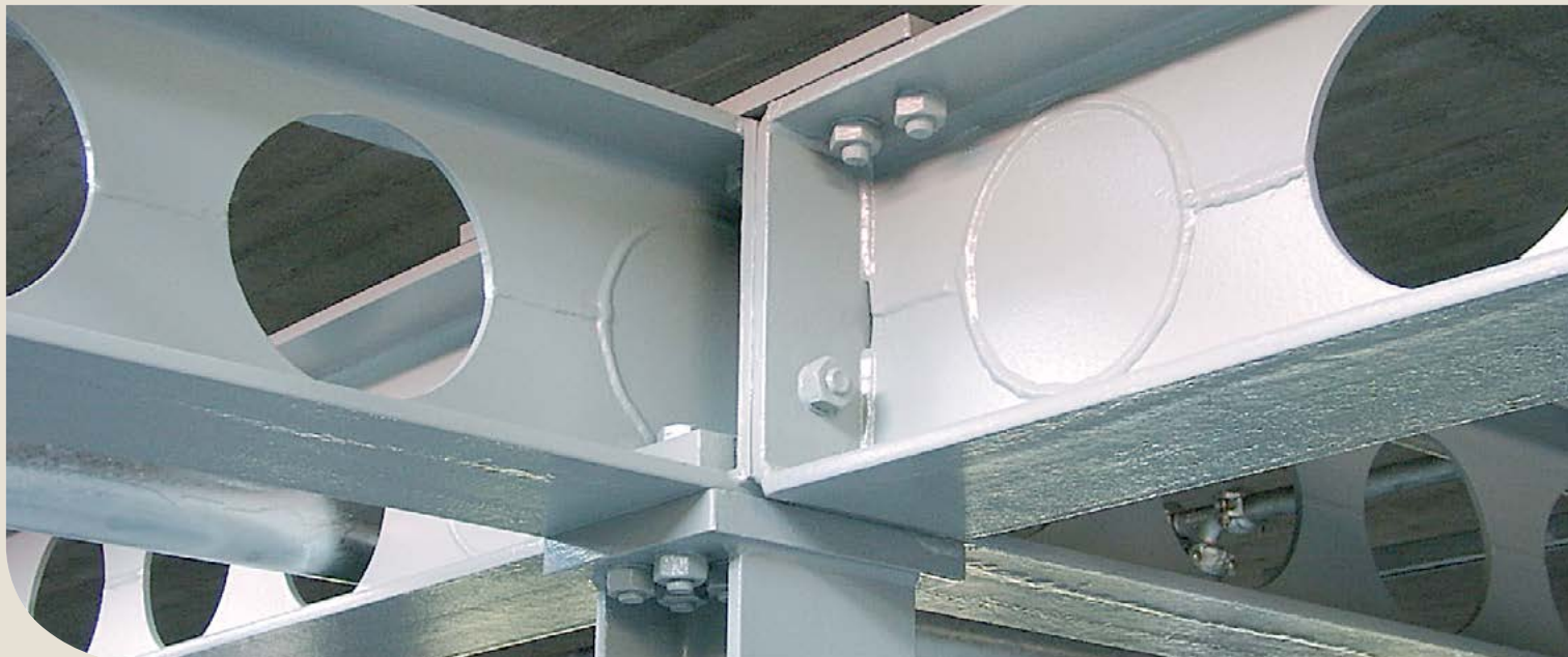
Exemple d'une poutre ACB® avec ouvertures obturées aux appuis
