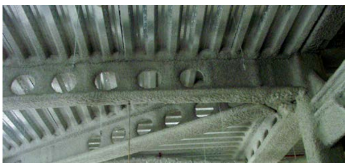
Figure 27: Protection par flocage d'une poutrelle ACB®
