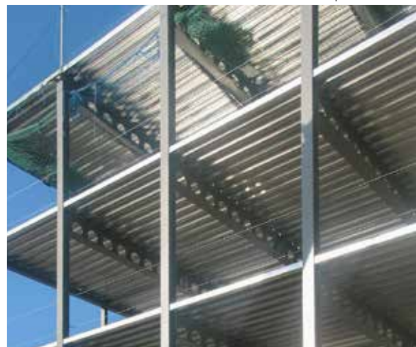
Staalbetonvloeren verminderen het eigen gewicht met ongeveer 50% ten opzichte van een gelijkwaardige betonnen vloer.
