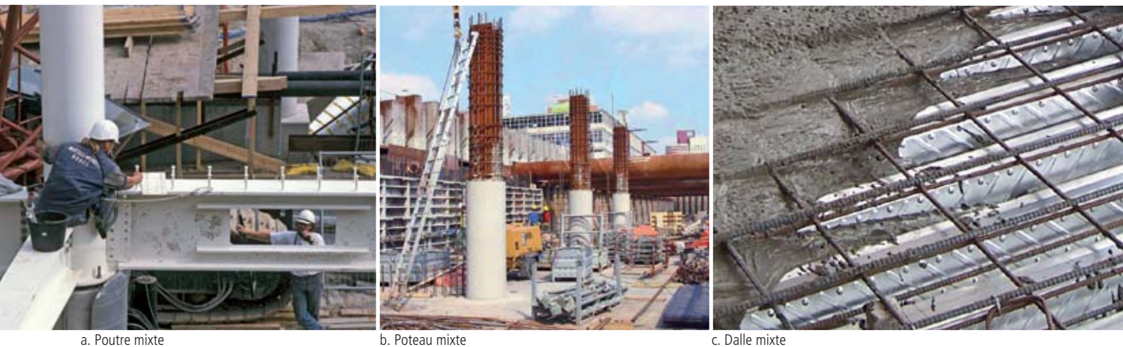
Figure 1-1 : Eléments structuraux de construction mixte
