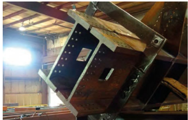
Deux profils soudés ensemble Two heavy sections welded together Zwei zusammenschweißte Profile
