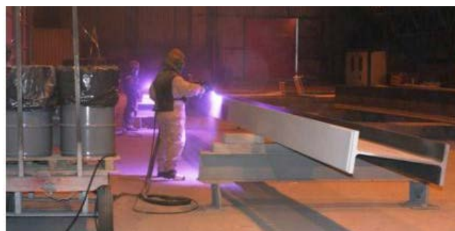
Manual metal spray zinc layer
