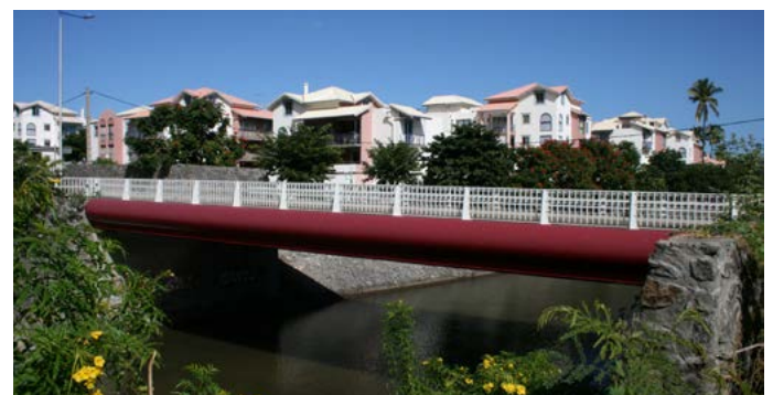
Pont de la Petite Ravine, Réunion Island, France
