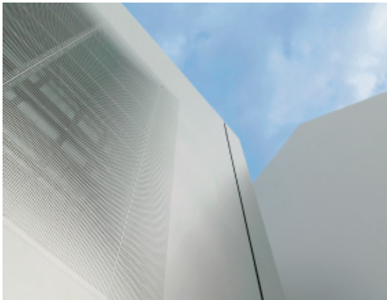
Roestvast stalen jaloezieën, met lasergesneden perforaties, dienen als zonnenscherm voor de ramen en liggen in één vloeiende lijn met de gevel.
