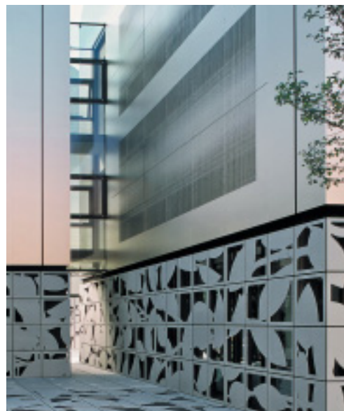
De voor het publiek toegankelijke ruimtes zijn gevestigd op de begane grond, achter drie meter hoge, decoratieve roestvast stalen panelen.
